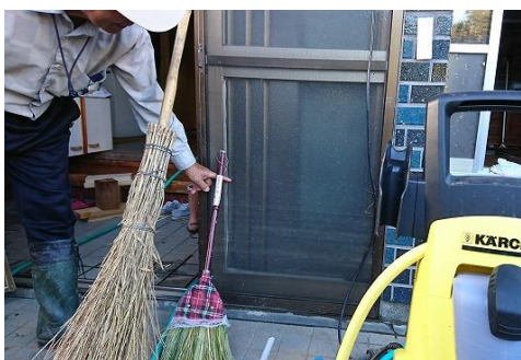
床上浸水位置
