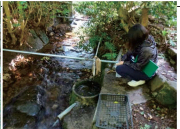
水汲み場（パイプで導水され蛇口になっている）
