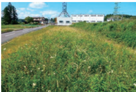
展望地（道路脇の盛土）の状況
