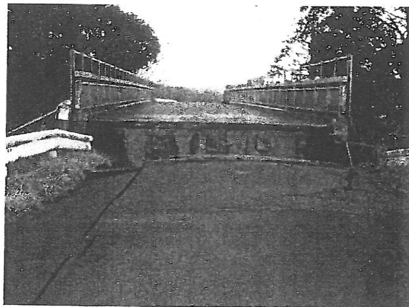
▲高速道跨道橋（宮橋）
